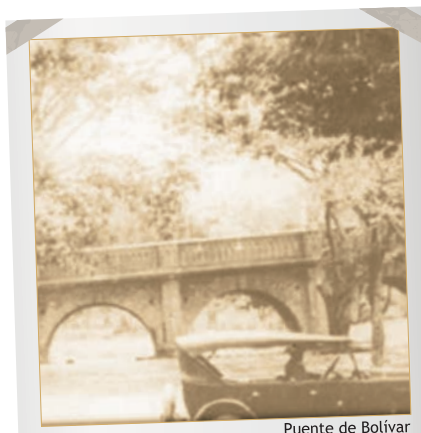
Puente de Bolívar
