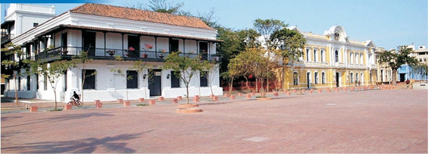
Nuevo aspecto del espacio público de la Plaza de Simón Bolívar en el marco de la ejecución del PEMP del Centro Histórico de Santa Marta.
